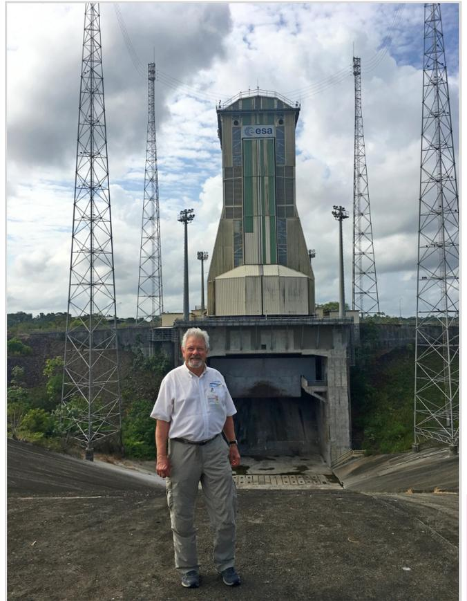
**Abb. 4:** Auf der Startrampe für die Soyus-Raketen. Im Hintergrund der Mobile Wartungsturm MSG, ca. 50 m hoch. In ihm wurde die Nutzlast auf die senkrecht stehende Trägerrakete montiert. Eine Stunde vor dem Start wurde er nach hinten zurückgefahren. Zu sehen sind auch die vier Blitzableiter-Masten, typisch für jeden Startplatz. Direkt hinter mir geht es abwärts in den Flammenkrater der Soyus-Rampe. Was aus dieser Anlage nach dem Abbruch der Beziehungen mit Russland wird, ist völlig offen.
