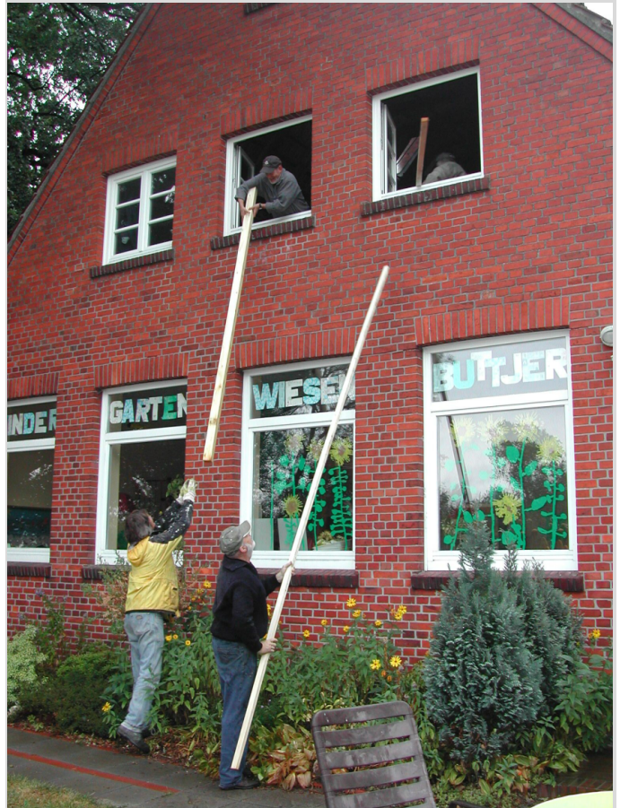
Abb. 4: Bauarbeiten am Vereinsheim.
