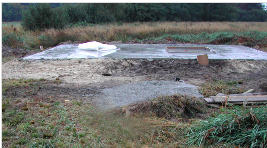
Abb. 2: Das Betonfundament auf dem Gelände der AVL vor der Errichtung der Sternwarten.
