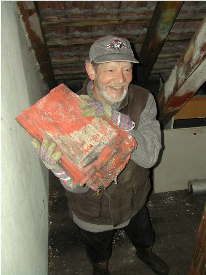
Abb. 3: Und es wird gebaut - hier ist Ernst-Jürgen Stracke fleißig.
