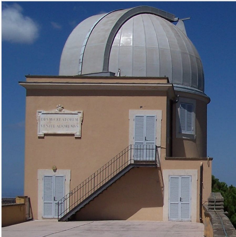
Abb. 2: Teleskopkuppel auf dem Dach des Papstpalastes zu Castel Gandolfo.
