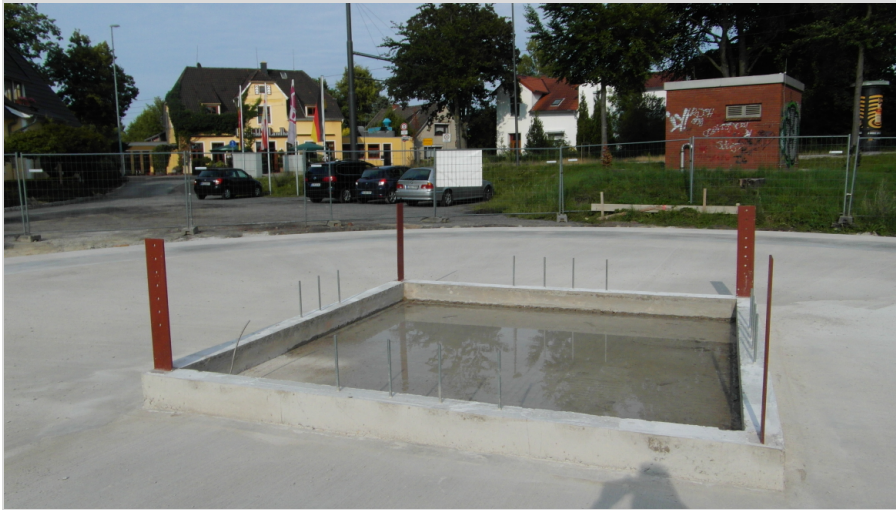
Abb. 4: Nachdem am 6. August 2015 der Sockel des Telescopium-Turmes in einer vierten Aktion gegossen und damit der Betonbau beendet war, füllte sich das „Becken“ in den nächsten Tagen immer mehr mit Regenwasser. Im Hintergrund das Borgfelder Landhaus, das im März 2023 abgerissen wurde.
