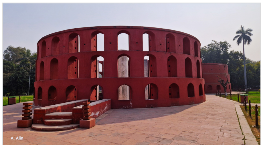
Abb. 5: Das Rama Yantra zu Delhi. Mittig durch die Fenster zu erkennen der Gnomon; im Hintergrund der zweite Zylinder.
