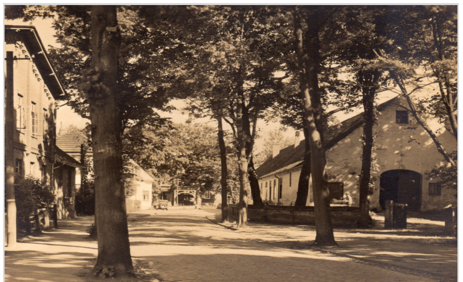
Abb. 7: Foto von 1933. Rechts: Das nach dem Brand von 1813 wiederaufgebaute Amtshaus. War von 1937-1977 nach einem Umbau Rathaus. Links, Früher Kornscheune und Gefängnis. Von 1852 -1971 Amtsgericht, heute Haus für kommunale Jugendarbeit.
