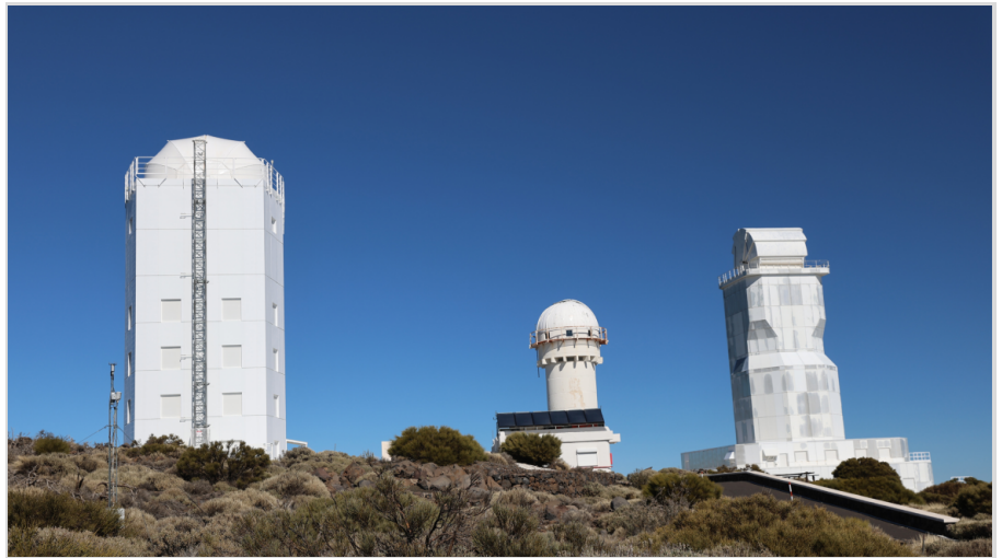
Abb. 6: Die beiden großen Sonnentelkope GREGOR und VTT (von links nach rechts).
