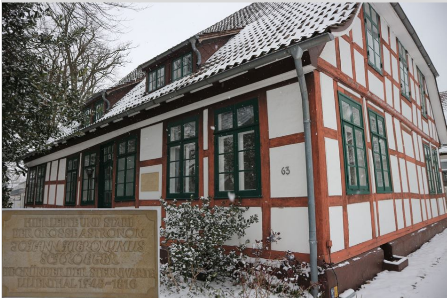
Abb. 6: Das Amtmann-Schroeter-Haus in der Hauptstraße 63 wird gut erhalten und ist heute eine Begegnungsstätte für Senioren; Aufnahme vom 19. Februar 2026.
