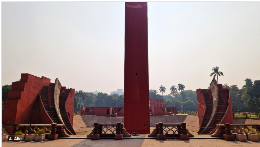
Abb. 4: Frontalansicht des Samrat Yantra. Mittig der Gnomon und an den Seiten gebogen die Quadranten und die Zugangstreppen.
