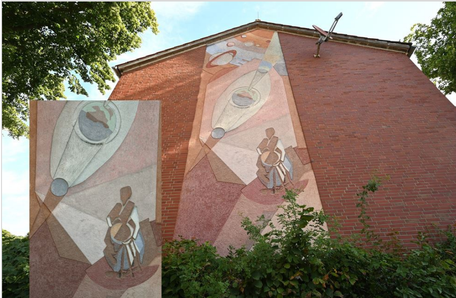
Abb. 2: Ein historisches Gebäude der Schroeterschule mit einem „Sgraffito“ auf der Giebelseite wurde im Herbst 2025 abgerissen. Der Ausschnitt befindet sich als Groß-Foto im Haupteingang des neuen Schulgebäudes.
