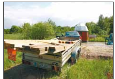
Mühselige Arbeit – die Materialanlieferung an der schwer zugänglichen Baustelle.
