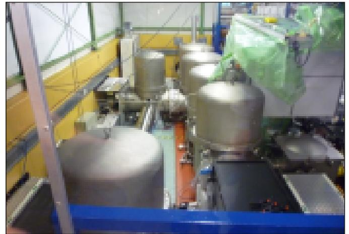
Abb. 6: Die sichtbaren „Tonnen“ sind die Vakuumpumpen für die 600 m langen Rohre des Interferometers.
