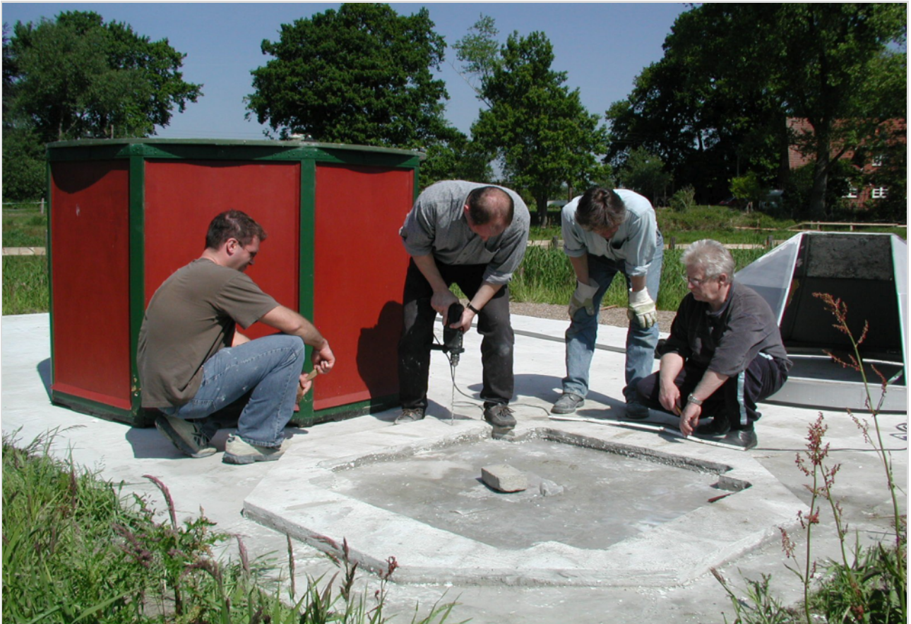
Abb. 10: Verankerung der Sternwarte auf der Plattform.
